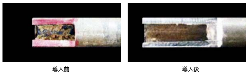
【Fig-07 冷却回路のスケールの比較】
